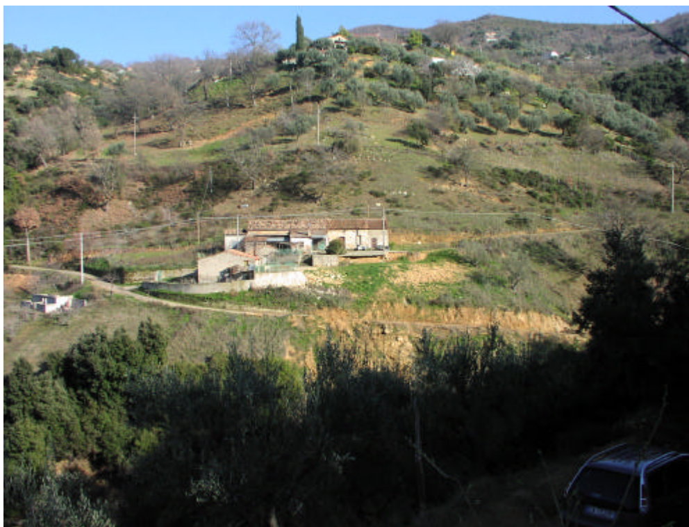
Fot.1 Area in frana con vista delle abitazioni evacuate
