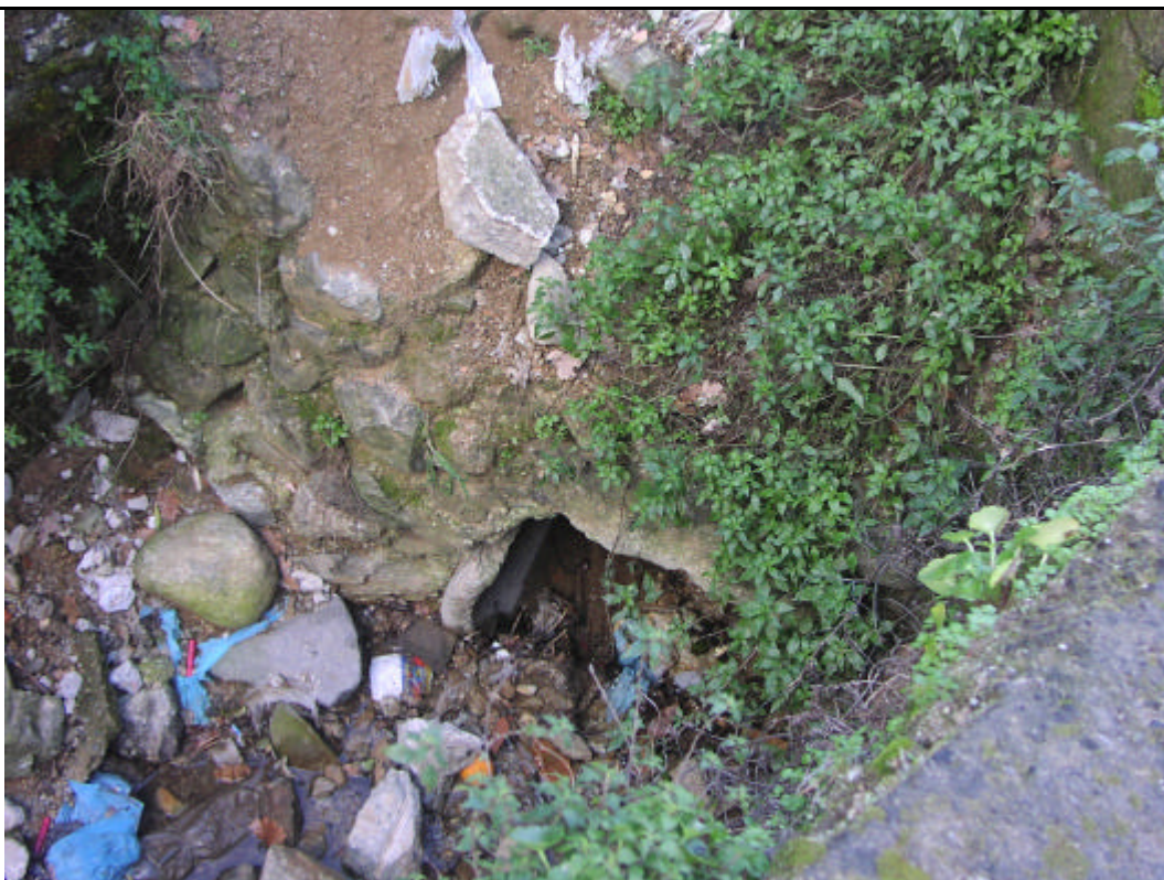
Fot.4 Vista del punto di imbocco del canale a monte
