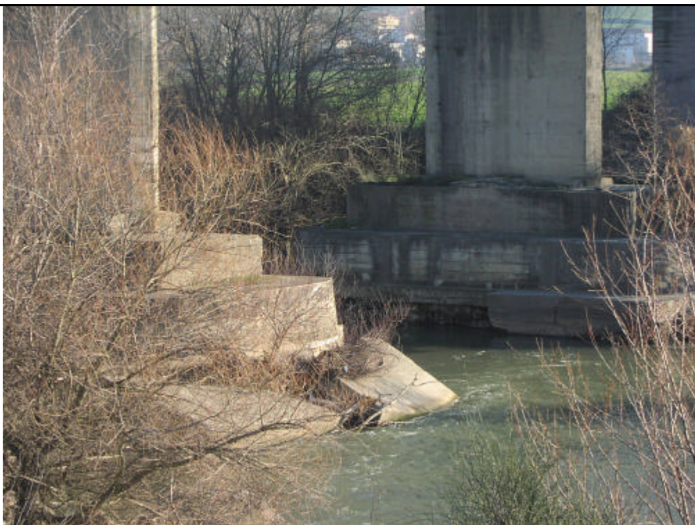
Fot.2 Particolare delle pile del ponte.
