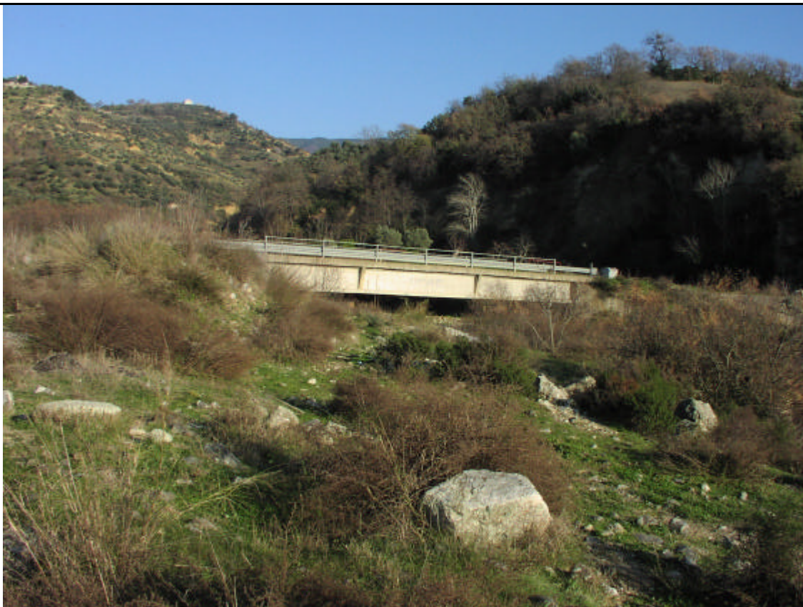
Fot.2 Attraversamento del T. Gidora e dell'alveo - vista da valle
