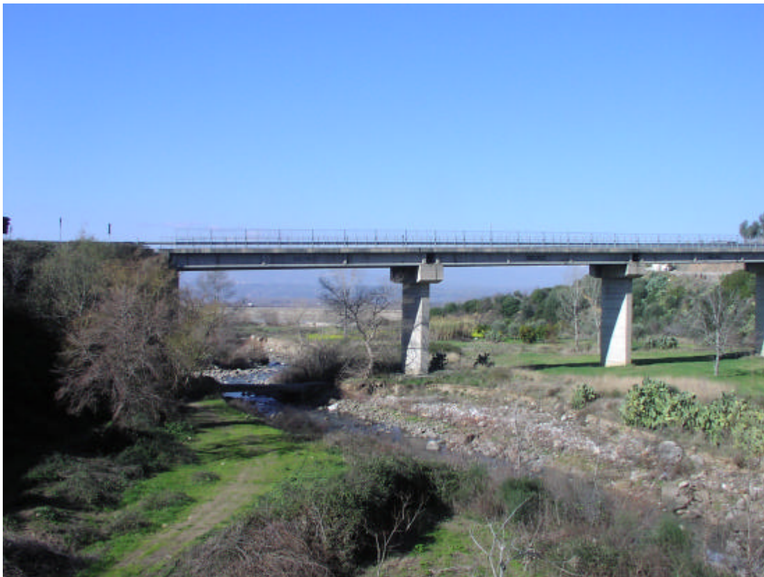
Fot.1 Attraversamento del Mucone con la SS 660.
