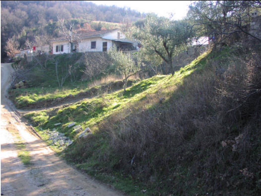
Fot.1 Vista della nicchia di distacco della frana
