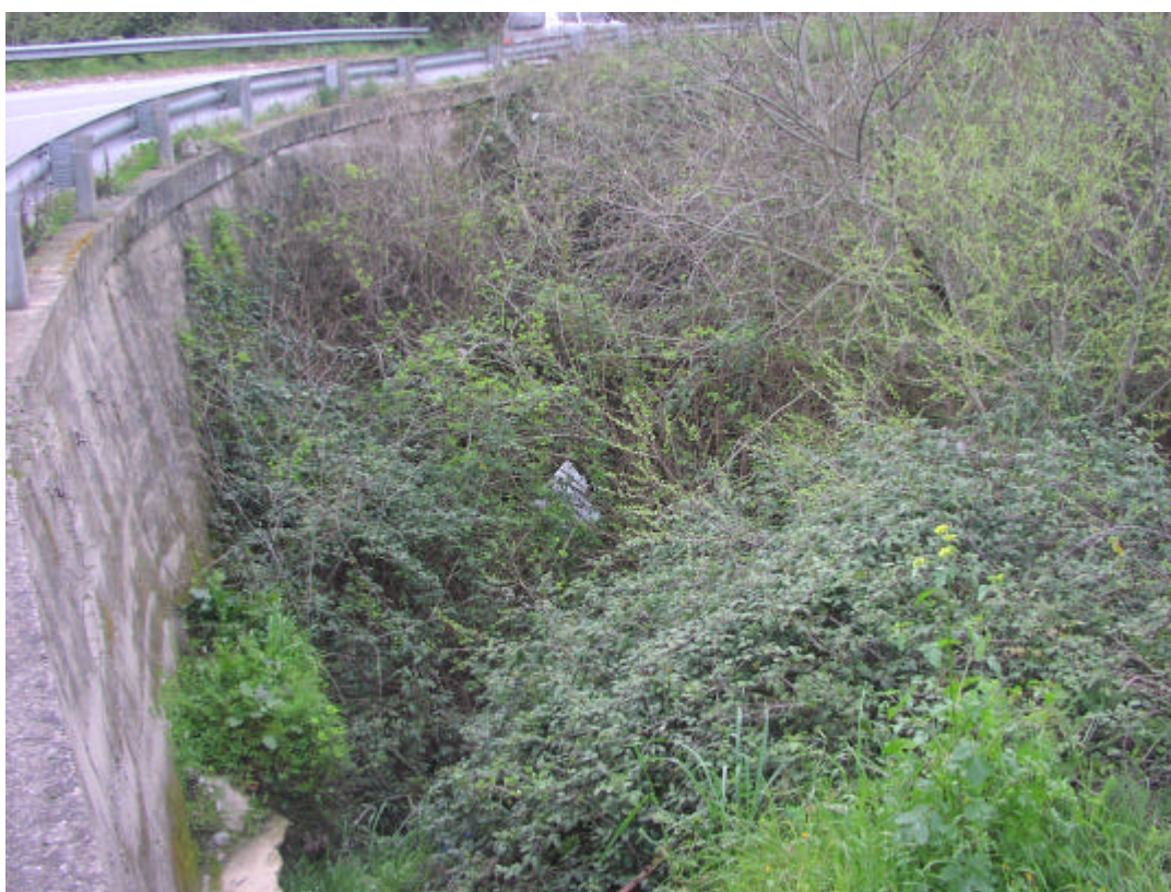
Fot.3 Vista del canale a valle dell'attraversamento.
