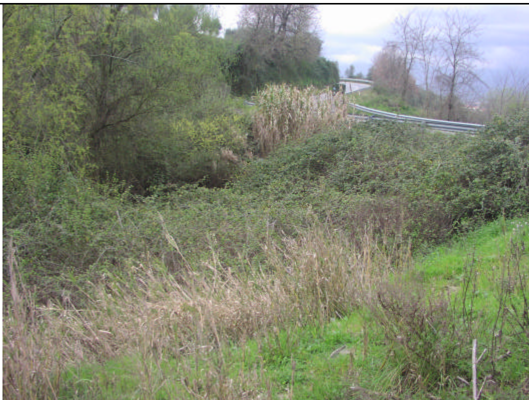
Fot.2 Vista del canale a monte dell'attraversamento
