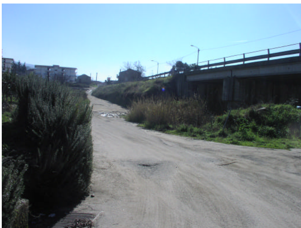
Fot.5 Vista dell'alveo a monte dell'attraversamento
