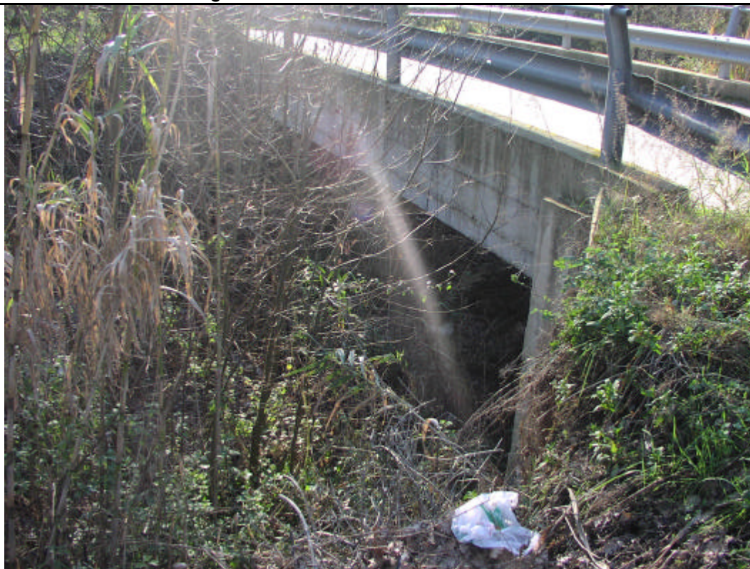
Fot.1 Attraversamento del Torrente Pescara con la Strada Comunale
