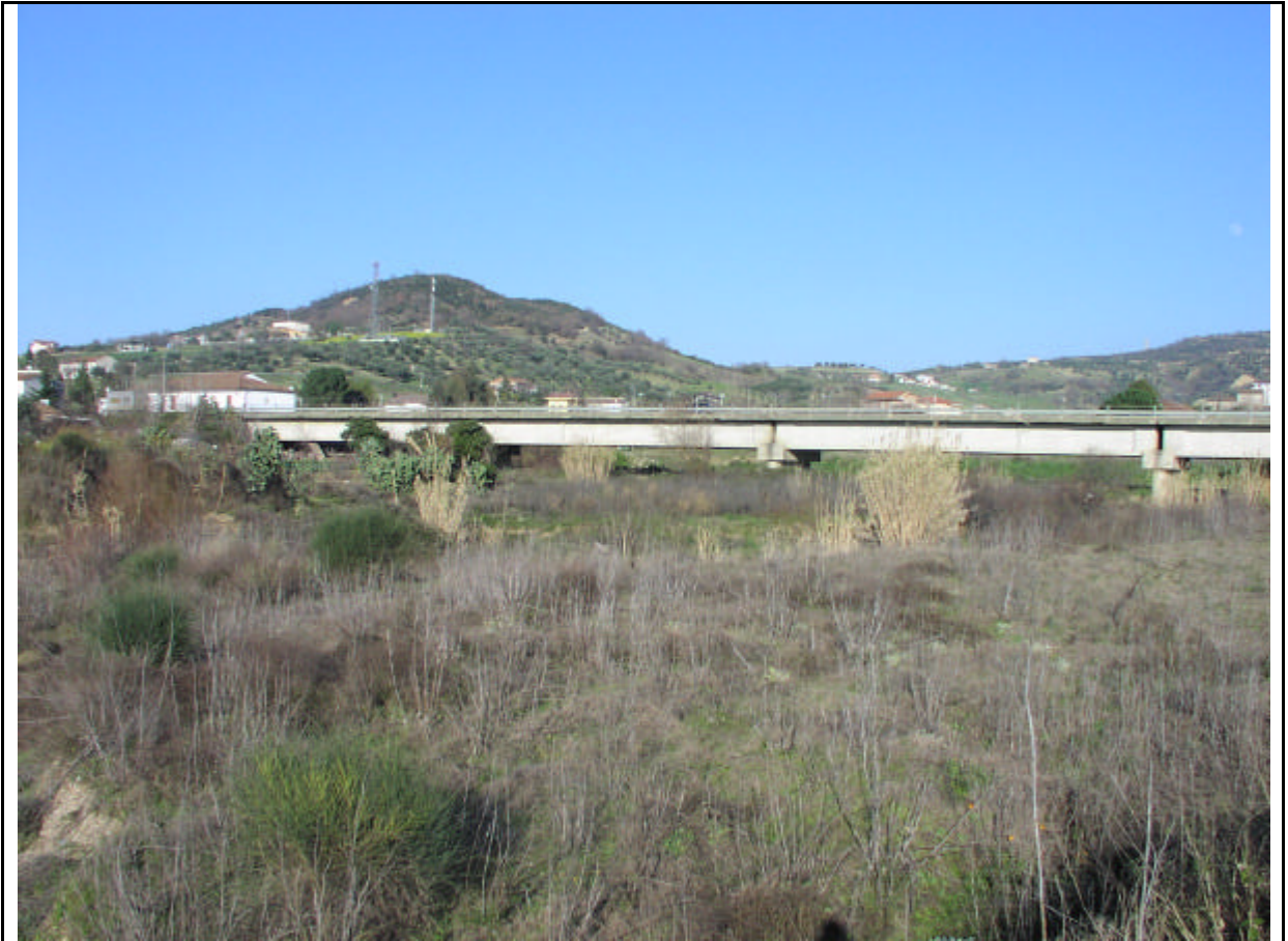
Fot.2 Vista da valle del Ponte della SP234 sul Torrente Risicoli.
