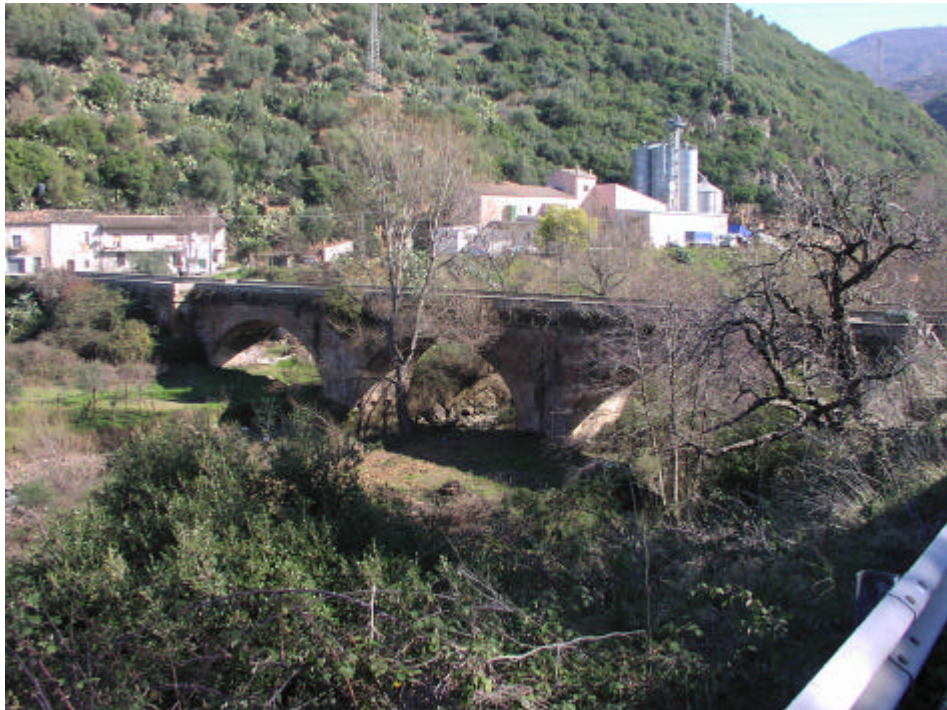
Fot.1 Attraversamento del T.Mucone in prossimità della Centrale Elettrica
