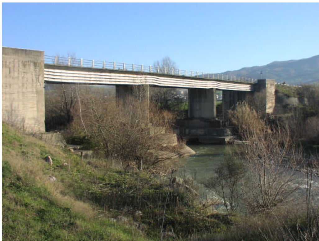
Fot.1 Ponte di attraversamento SP248-Fiume Crati.
