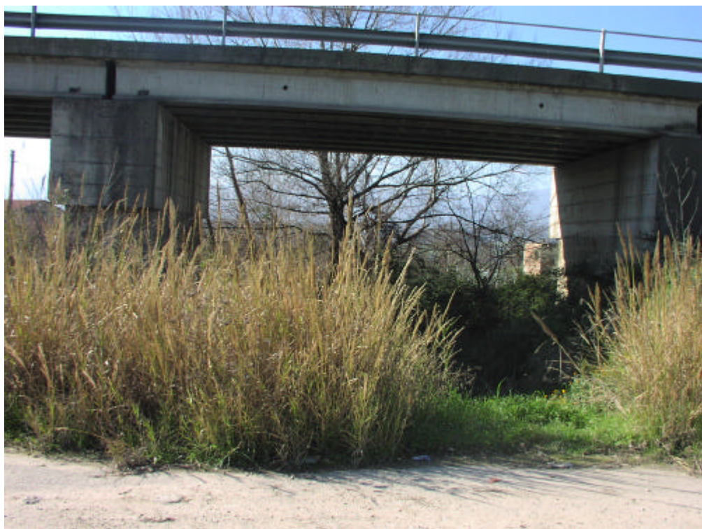
Fot.4 Vista del ponte della SS660
