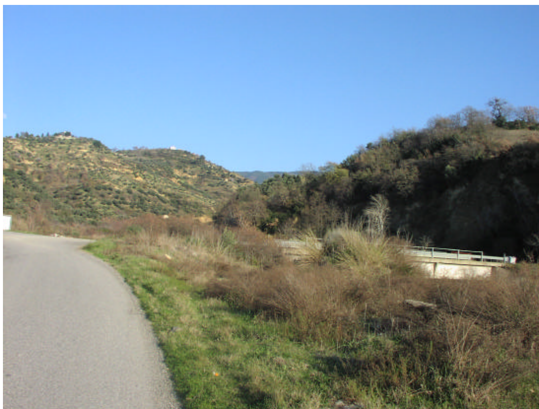
Fot.3 Attraversamento del T. Gidora e dell'alveo - vista da valle
