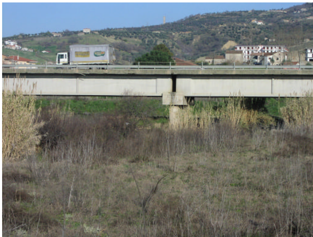
Fot.1 Alveo del T.Riscicoli nell'attraversamento con la SP234.
