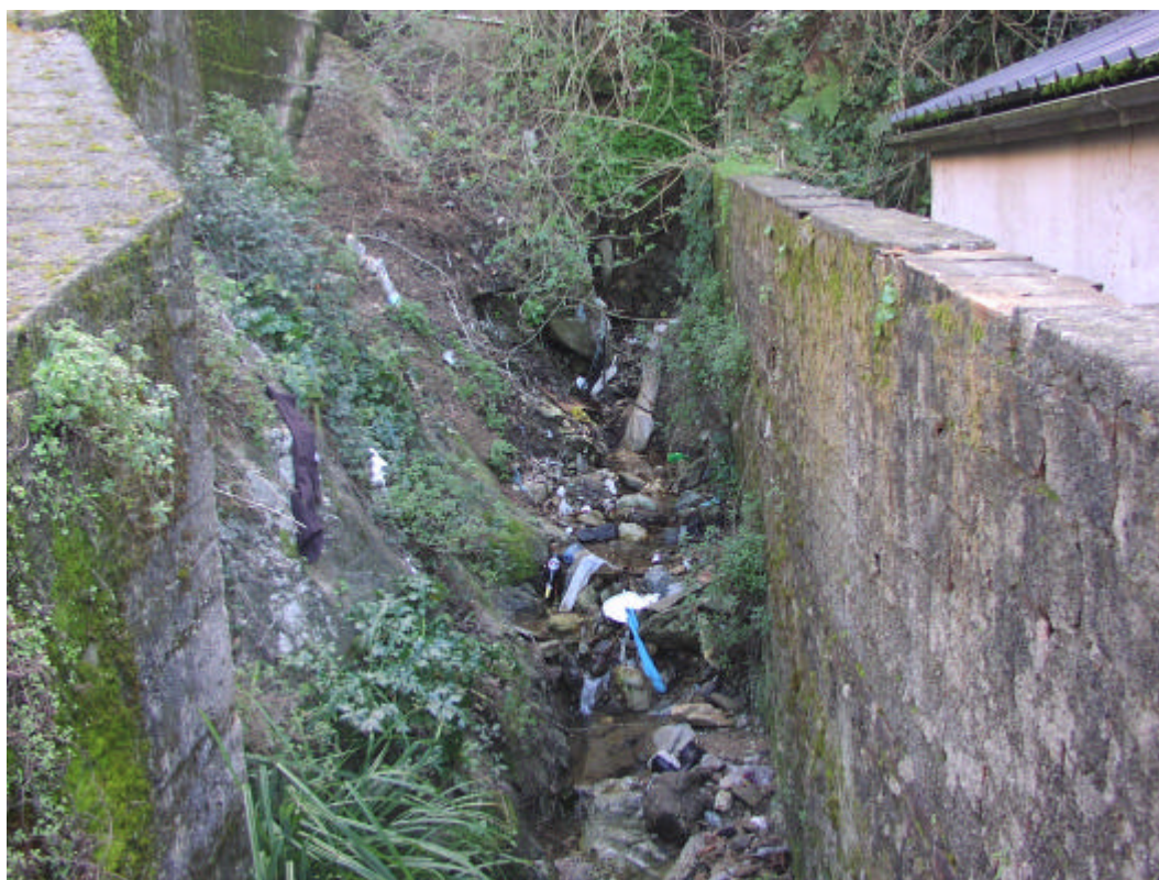
Fot.3 Vista del canale che convoglia le acque a monte dell'imbocco
